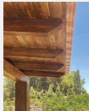
TERMINACIÓN PUNTA DIAGONAL
