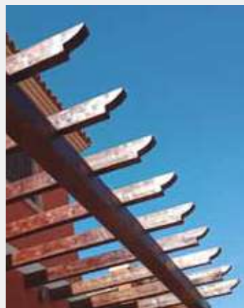
TERMINACIÓN PUNTA MALLORCA
